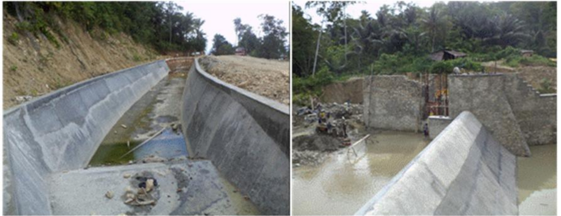
Gambar 4.9. Waterway dan Bendung PLTM Lambangan (Sumber: Survei, 2013)
