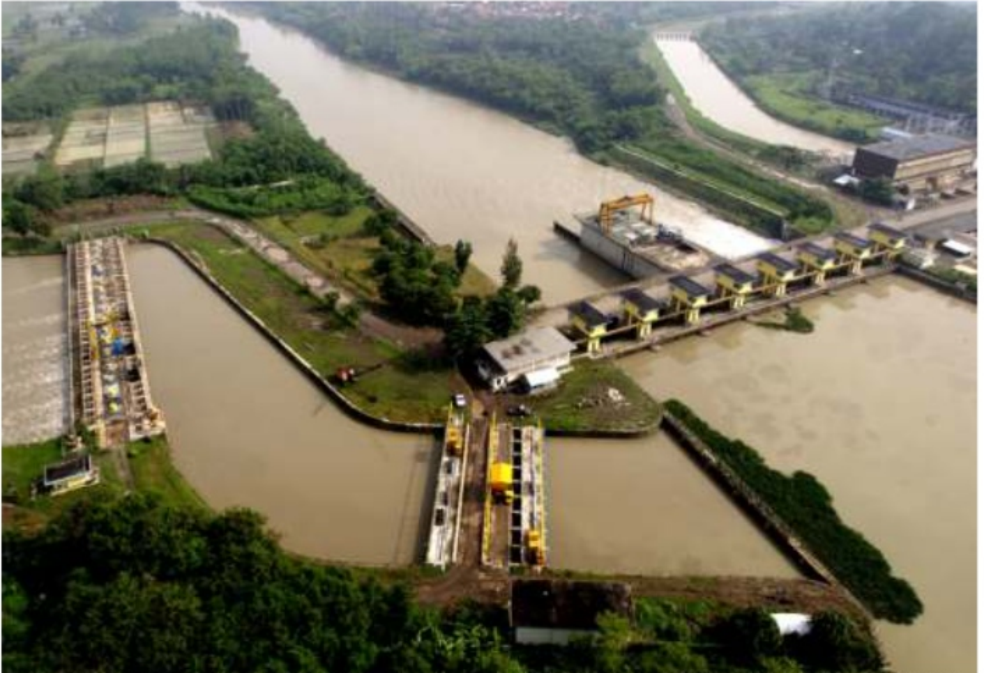
Selepas Waduk Jatiluhur air Sungai Citarum didistribusikan melalui bangunan-bangunan pembagi salah satunya adalah bendung Curug yang membagi air Citarum ke Saluran Tarum Barat dan Saluran Tarum Timur (atas).
