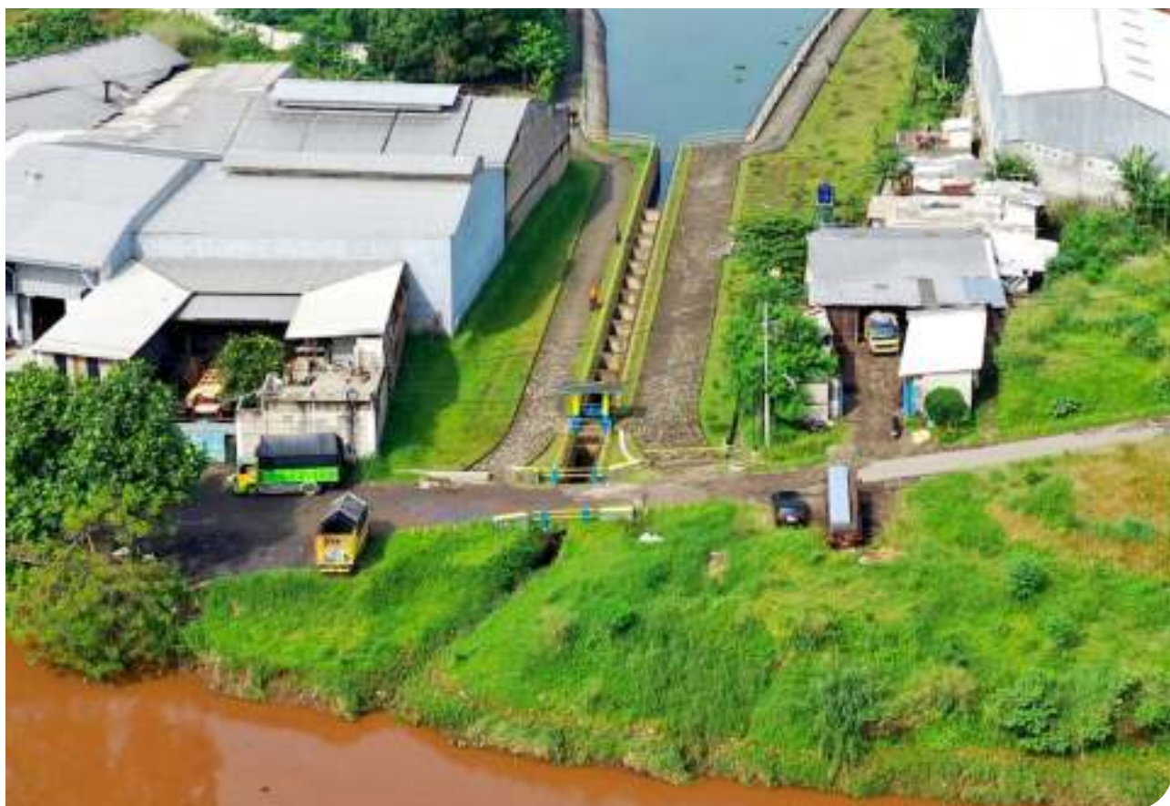
Sedimen trap pada inlet untuk mengendapkan sedimen dari Sungai Citarum sebelum masuk ke oxbow
