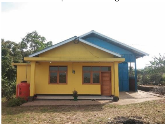
TPS 3R Desa Margaluyu, Kabupaten Sumedang
