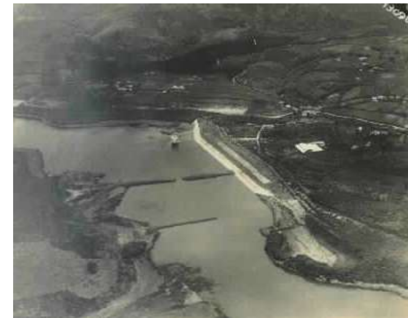
Pembangunan Bendungan Cileunca mulai dilaksanakan pada masa Kolonial Belanda.
