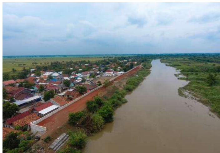
Foto : Pada Tahun 2022 BBWS Citarum Menyelesaikan Pekerjaan Pembangunan Tanggul Permanen di Kampung Sumber Urip
