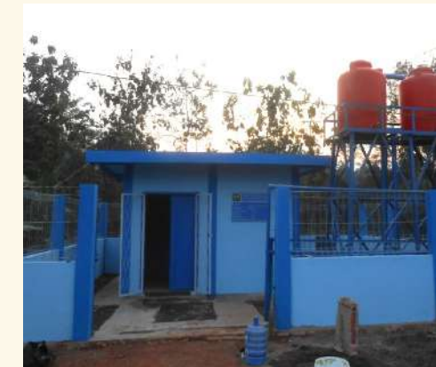
Pekerjaan Pembangunan Rumah Pompa Dan Jaringan Irigasi JIAT Perpipaan berikut Sarana Air Baku 5 (Lima) Lokasi Di Kabupaten Indramayu
