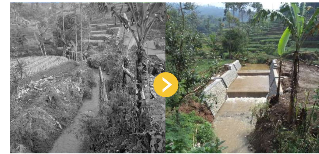
Sungai Cisaat Bagian Hulu Jembatan
