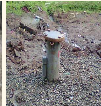
Pekerjaan Sumur Produksi 3 (Tiga) Titik di Kabupaten Bandung Barat
