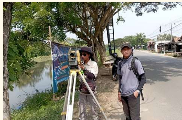
Rehabilitasi Saluran Induk Tarum Utara (B. Lewung Seureuh - B. TUB 26)
