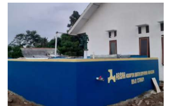
Kecamatan Sindangbarang Kabupaten Cianjur TA. 2021
