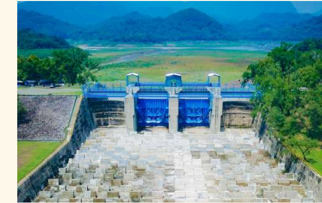
Pekerjaan Pemasangan Pintu Radial Pada Emergency Auxiliary Spillway Bendungan Jatiluhur di Ubrug, Kabupaten Purwakarta
