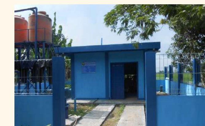
Pekerjaan Rehabilitasi Rumah Pompa Dan JIAT Perpipaan Sarana Air Baku 10 (Sepuluh) Lokasi
