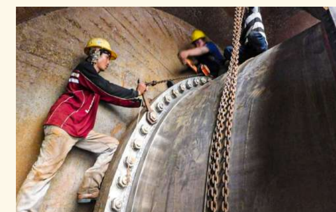
Penggantian peralatan mekanikal elektrik /Hollowcone valve (HCV) pada Bendungan Jatiluhur, Kabupaten Purwakarta
