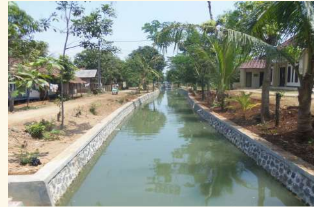
Rehabilitasi Jaringan Irigasi DI. Cihea Kab. Cianjur
