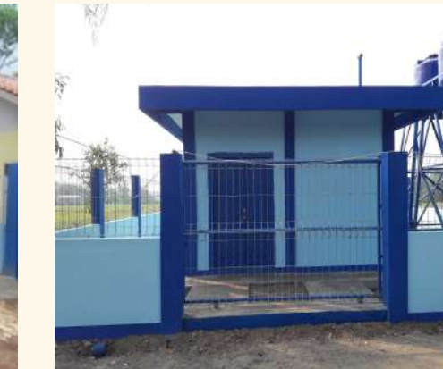
Pekerjaan Pembangunan Rumah Pompa Dan Jaringan Irigasi JIAT Perpipaan berikut Sarana Air Baku 4 (Empat) Lokasi Di Kabupaten Cianjur
