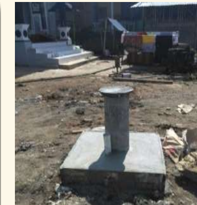
Pekerjaan Sumur Produksi 4 (Empat) Titik di Kabupaten Cianjur
