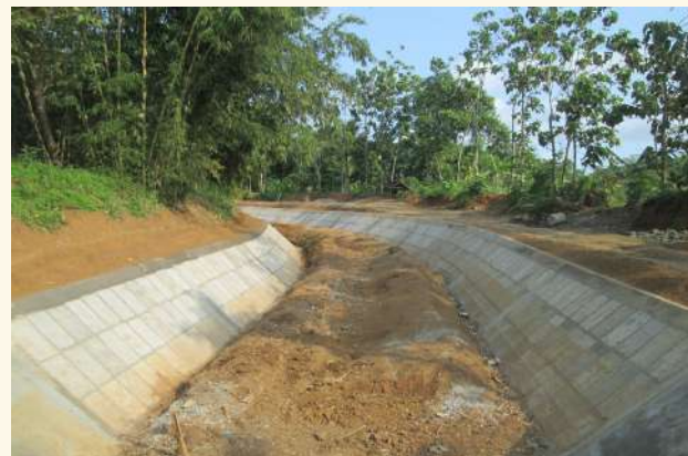
Rehabilitasi Jaringan Irigasi DI Ciletuh di Kab. Sukabumi
