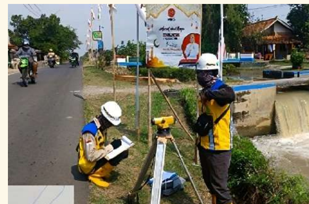
Rehabilitasi/Peningkatan/Modernisasi Jaringan Irigasi SS Kandang Haur Cs, SS. Eretan Cs
