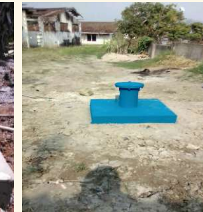
Pekerjaan Sumur Produksi 4 (Empat) Titik di Kabupaten Bandung
