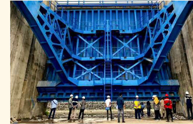
Pekerjaan Pemasangan Pintu Radial Pada Emergency Auxiliary Spillway Bendungan Jatiluhur di Ubrug, Kabupaten Purwakarta
