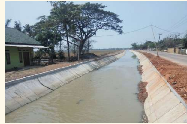
Rehabilitasi Jaringan Irigasi Rengas Bandung II Cs di Kab. Bekasi
