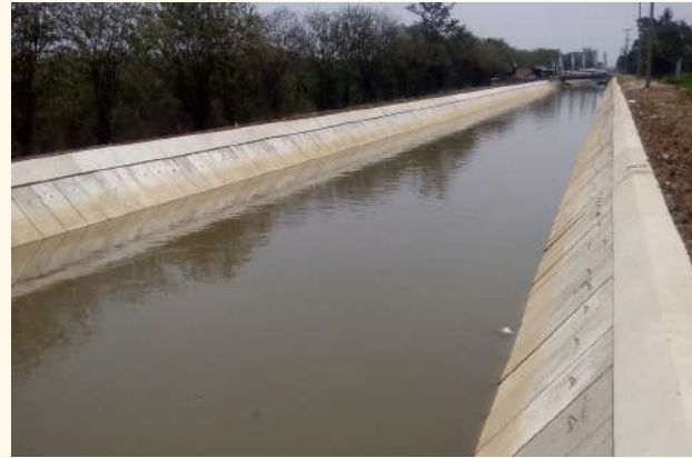
Rehabilitasi Jaringan Irigasi SS Bulak Mangga I Cs di Kab. Bekasi
