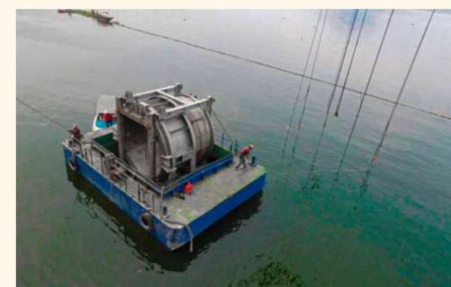
Penggantian peralatan mekanikal elektrik /Hollowcone valve (HCV) pada Bendungan Jatiluhur, Kabupaten Purwakarta
