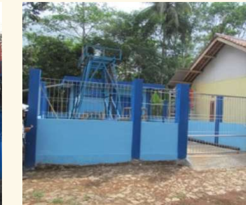
Pekerjaan Pembangunan Rumah Pompa Dan Jaringan Irigasi JIAT Perpipaan berikut Sarana Air Baku 3 (Tiga) Lokasi Di Kabupaten Bandung Barat
