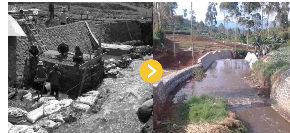
Sungai Cangkuang Bagian Hilir Jembatan
