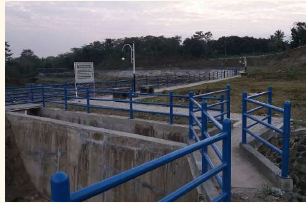
Pembangunan Prasarana Bendung Leuwinangka di Kab. Subang
