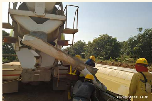
Rehabilitasi, Peningkatan dan Modernisasi Jaringan Irigasi SS Salamdarma Kiri Cs, SS Gadung Cs, SS. Pawelutan CS
