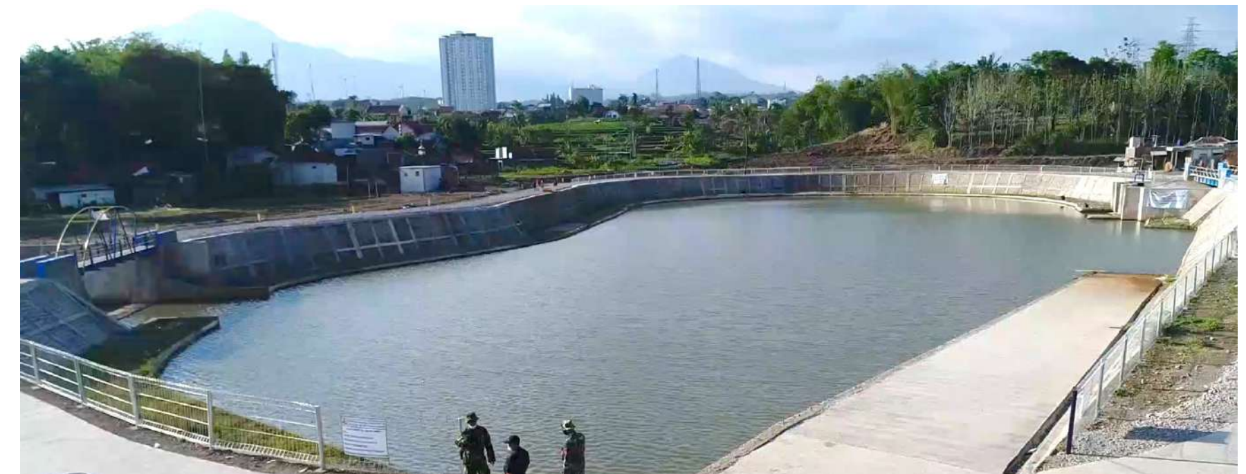
Fungsi dari sediment trap ini sebagai tangkapan sedimen dari anak Sungai Citarum agar tidak terbawa langsung ke Sungai Citarum. Fungsi lainnya juga diharapkan akan mengurangi banjir yang ada di Desa Cikeruh dan Hegarmanah
