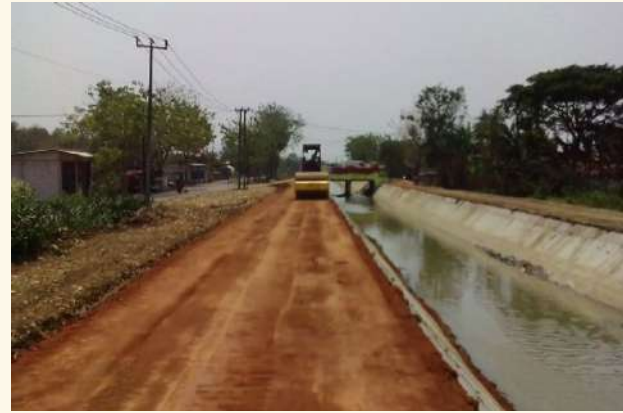
Pembangunan Prasarana Bendung Leuwinangka di Kab. Subang
