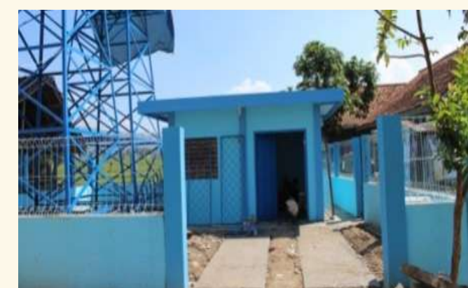
Pekerjaan Pembangunan Rumah Pompa Dan Jaringan Irigasi JIAT Perpipaan berikut Sarana Air Baku 4 (Empat) Lokasi Di Kabupaten Bandung
