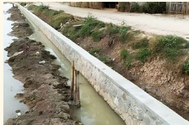
Rehabilitasi, Peningkatan dan Modernisasi Jaringan Irigasi SS. Lamaya Barat Cs
