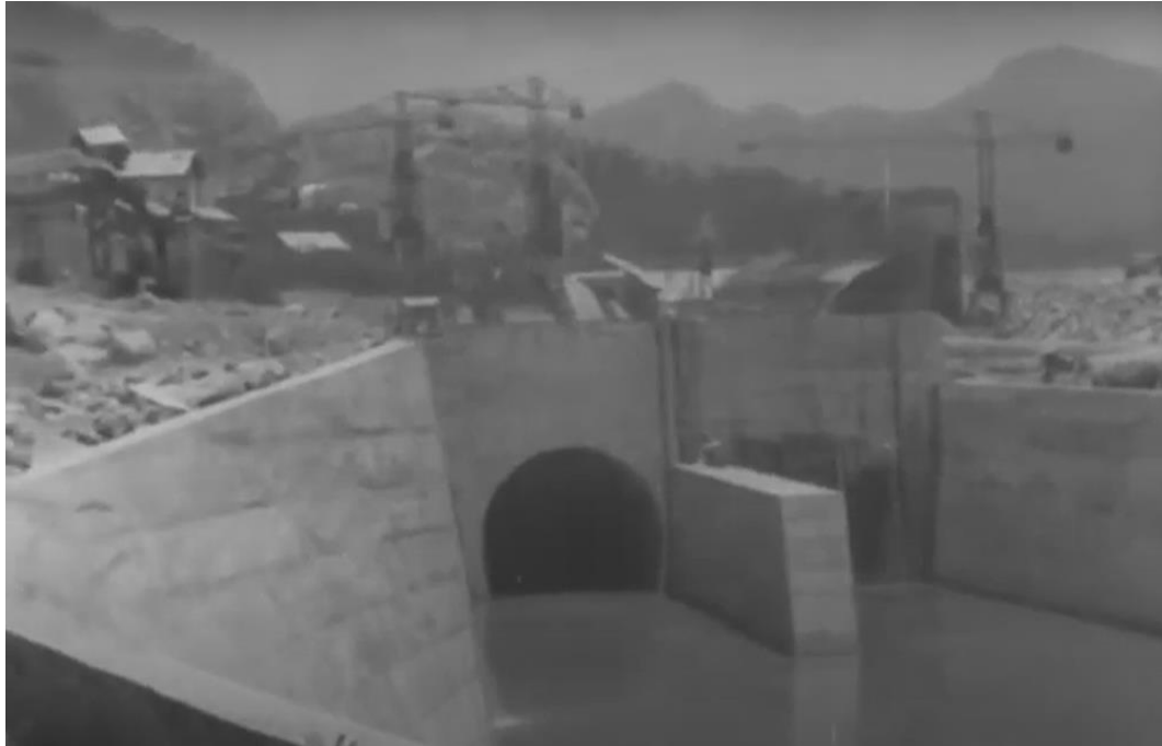
Gambar 2.4 Proses pembangunan Bandungan Jatiluhur pada tahun 1961 (Tangkap Layar Youtube Chandramatchbox channel)
