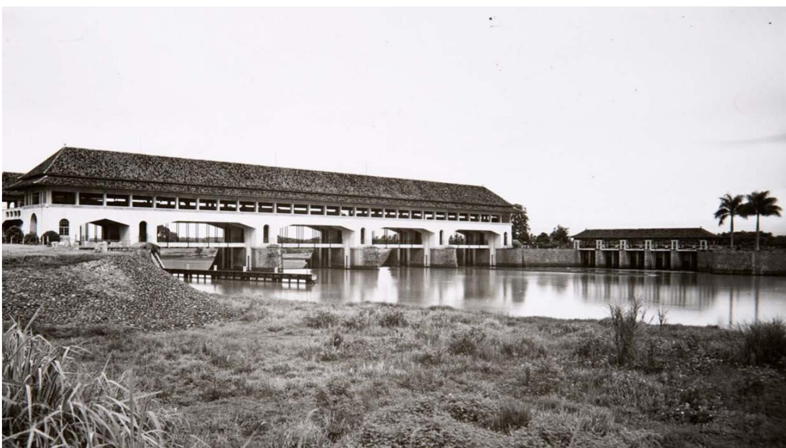
Gambar 2.3 Bendung Walahar pada tahun 1920-1935 yang berada di
