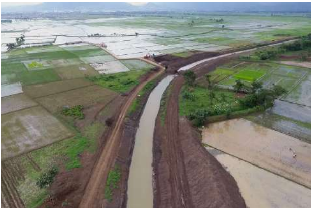
Peningkatan Kapasitas Sungai Cimande, Kab Bandung
