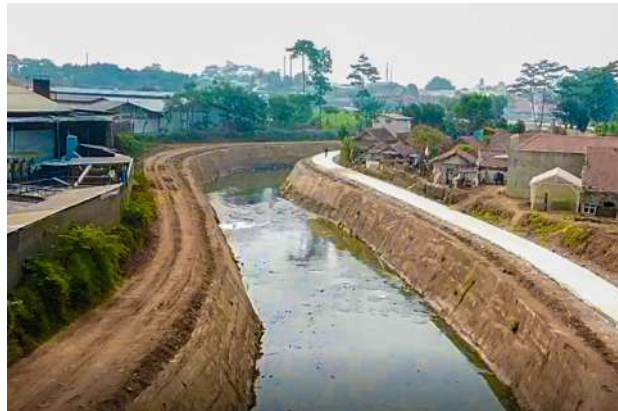
Peningkatan Kapasitas Sungai Citarum Hulu, Kab Bandung
