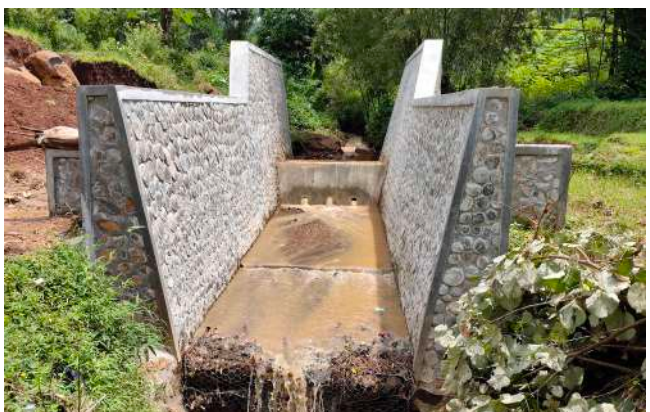
Pengendali Sedimen (Checkdam) di Anak Sungai Citarum Hulu tersebar
