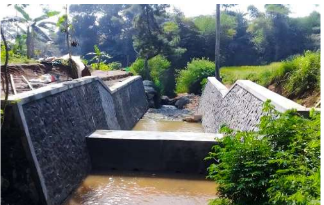
Pengendali Sedimen (Checkdam) di Anak Sungai Citarum Hulu tersebar
