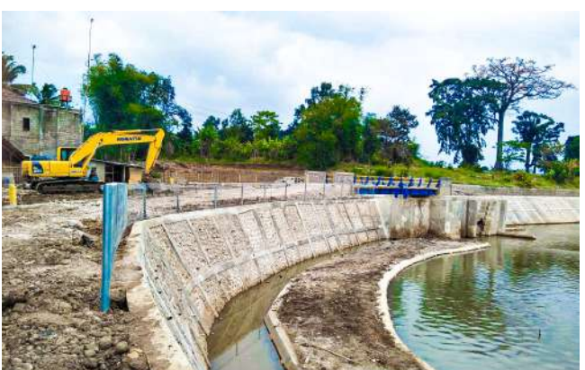
Pengendali Sedimen (Sediment Trap) di Sungai Cikeruh, Kabupaten Bandung
