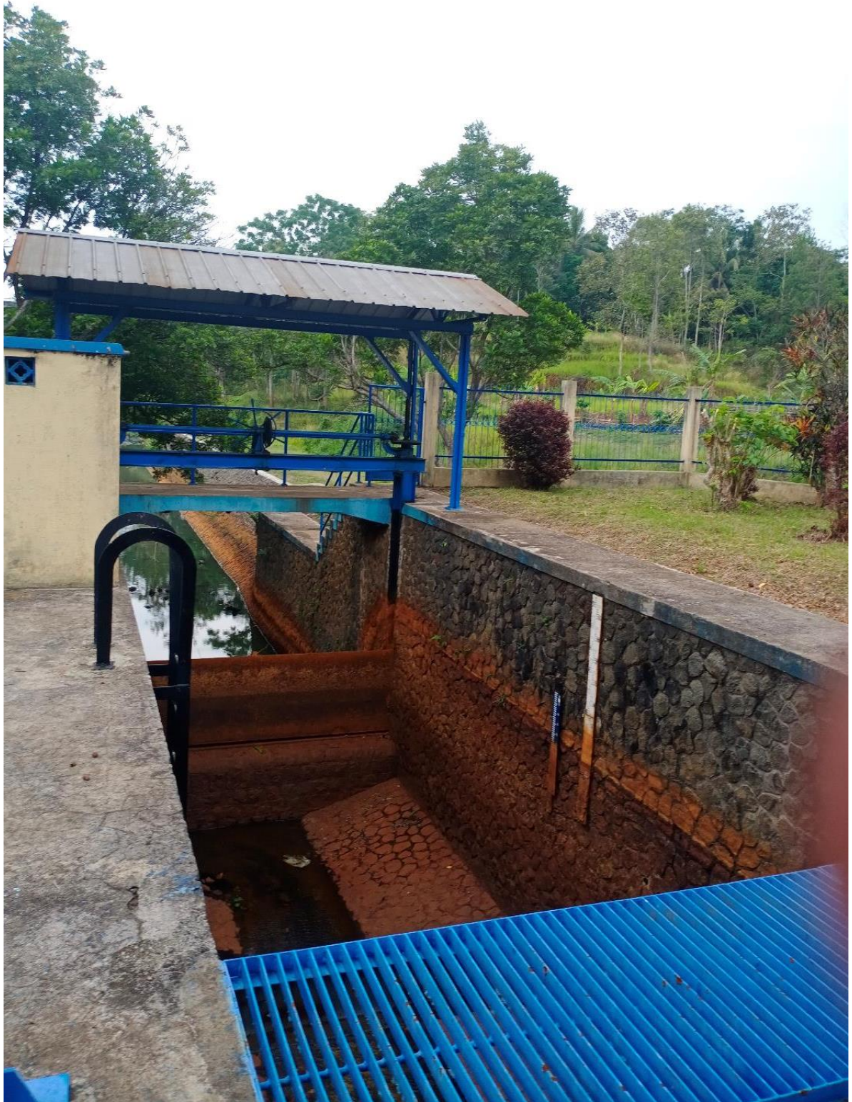
Pintu air di hilir outlet
