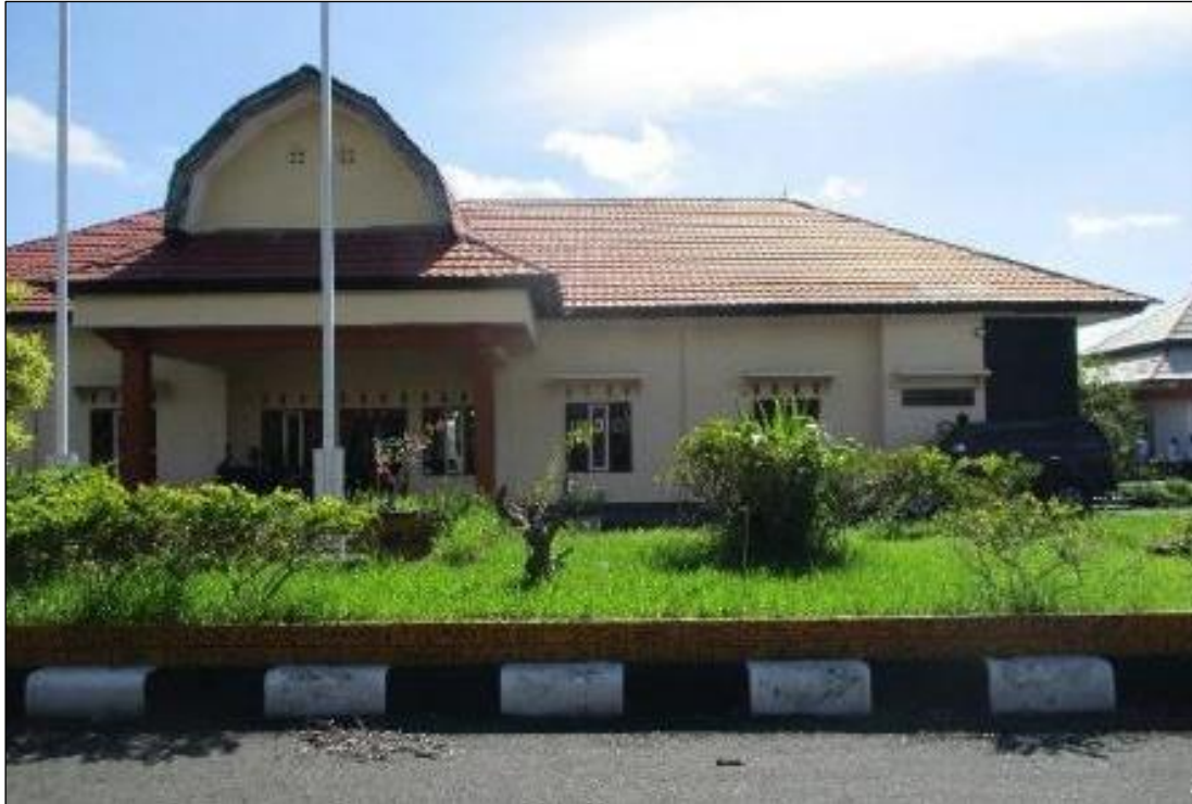
Gambar 2.31 Kantor Lapangan Petugas Bendungan Pandanduri
