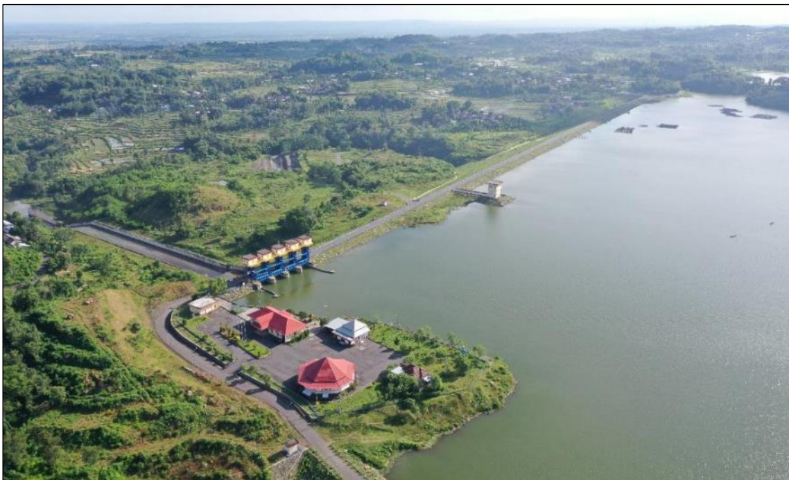
Gambar 2.28 Bendungan Pandanduri, Kabupaten Lombok Timur, Provinsi Nusa Tenggara Barat
