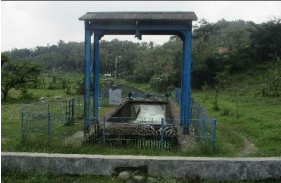
Gambar 2.21 Bangunan Pengeluaran Irigasi
