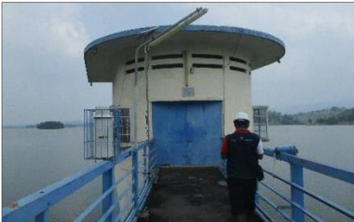
Gambar 2.20 Bangunan Menara Pengambilan
