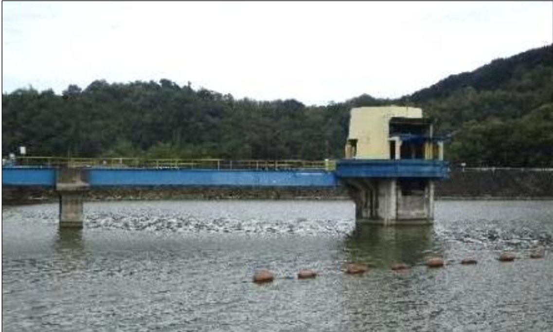
Gambar 2.15 Bangunan Menara Pengambilan Waduk Sermo
