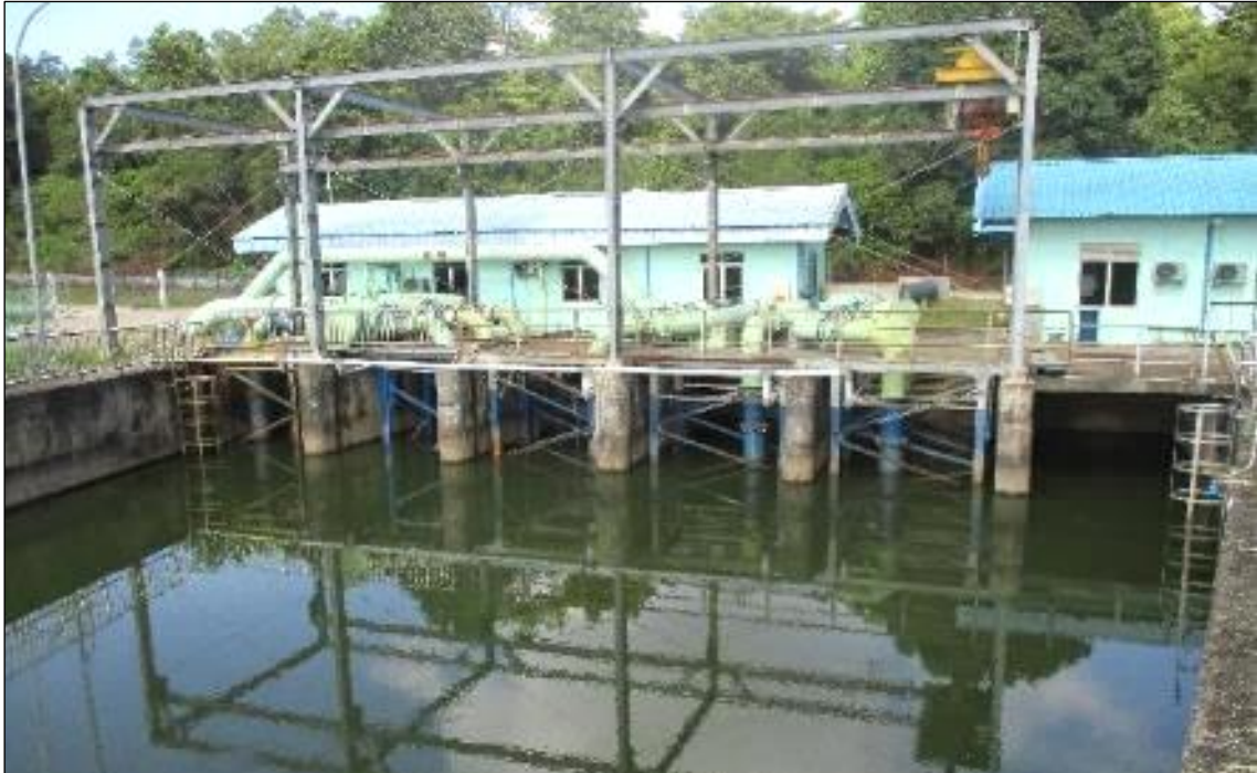
Gambar 2.25 Bangunan Pengambilan Waduk Duriangkang
