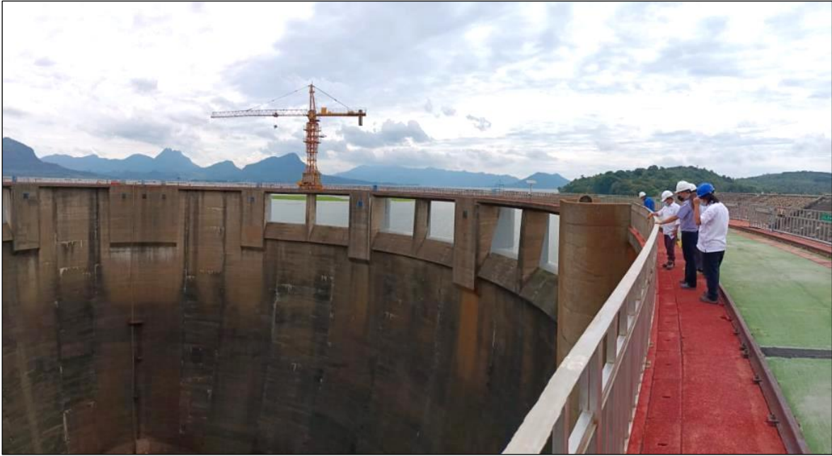
Gambar 2.3 Pelimpah/ Spillway Tipe Morning Glory Bendungan Jatiluhur
