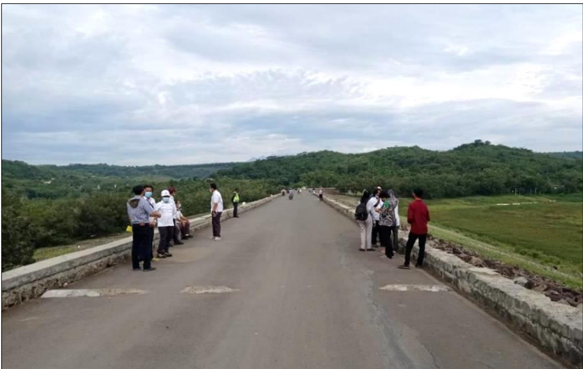
Gambar 2.4 Bendungan Pelana ( Saddle Dam ) Ubrug
