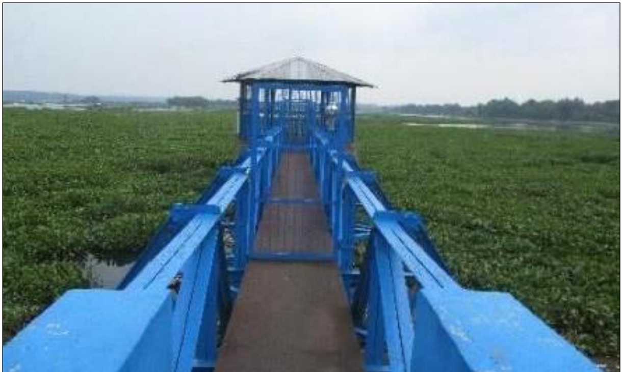
Gambar 2.10 Bangunan Jembatan Layan dan Menara Pengambilan Waduk Cengklik
