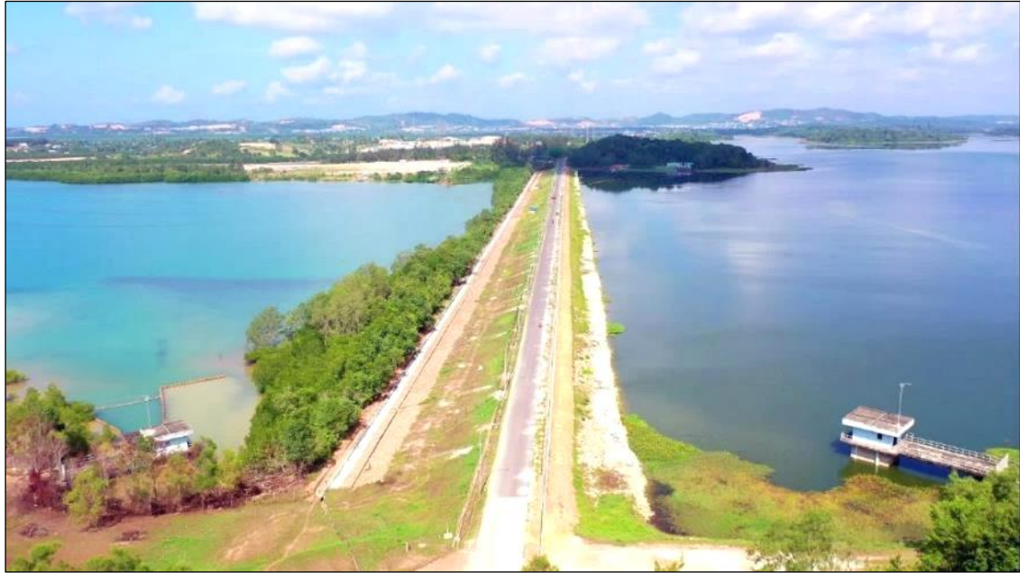
Gambar 2.23 Bendungan Duriangkang di Batam
