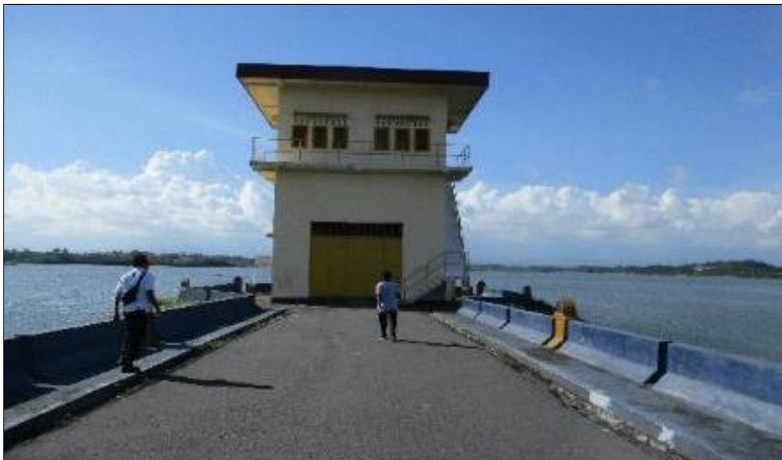
Gambar 2.32 Bangunan Menara Pengambilan/ Intake
