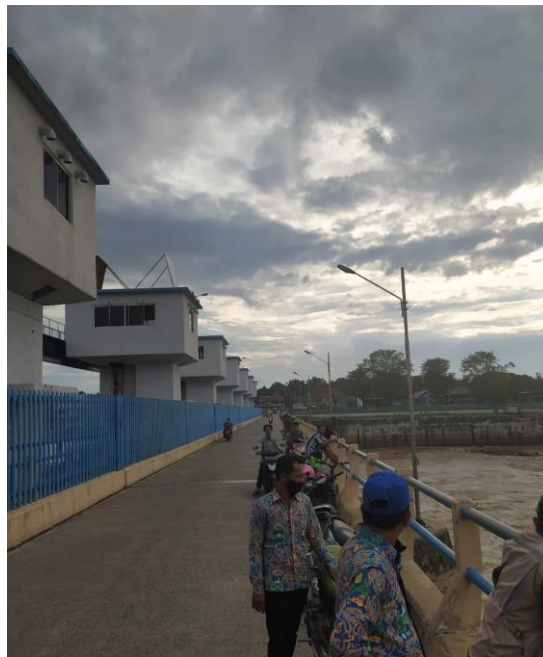
Gambar 17 Tampak Jembatan Bendung Perjaya
