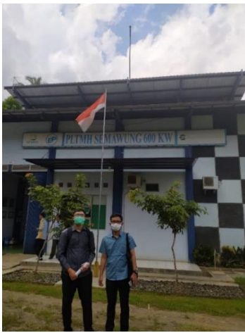
Foto 9. Power House PLTMH Semawung Tampak Depan
