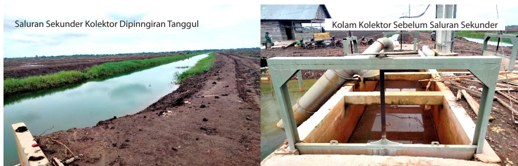
Gambar 6.38 Saluran Sekunder Kolektor dan Kolam Kolektor Sumber : Direktorat Pengairan dan Irigasi, Bappenas
