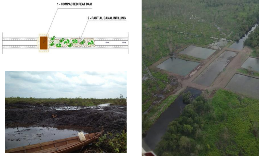
Gambar 7.2 Penimbunan Kanal (Canal Back Filling) Sumber : Deltares, I Nyoman N. Suryadiputra (2005), Azwar Maas (2019)
