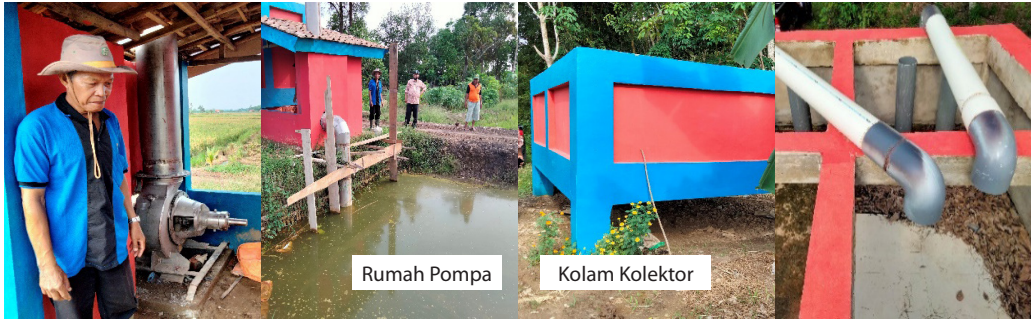
Gambar 6.44 Rumah Pompa dan Kolam Kolektor Sumber : Direktorat Pengairan dan Irigasi, Bappenas
