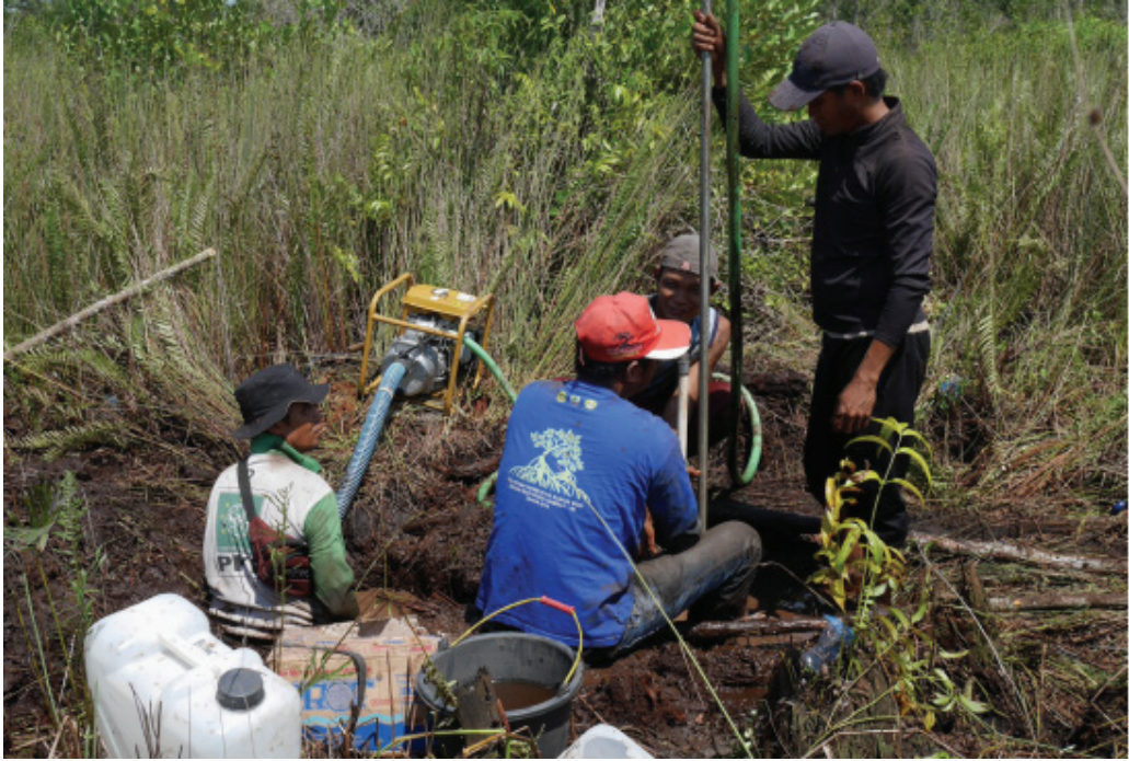
Gambar 2.12 BRG Bekerja Sama dengan Kelompok Masyarakat Melakukan Pembangunan Infrastruktur Pembasahan Gambut, yaitu Sumur Bor
