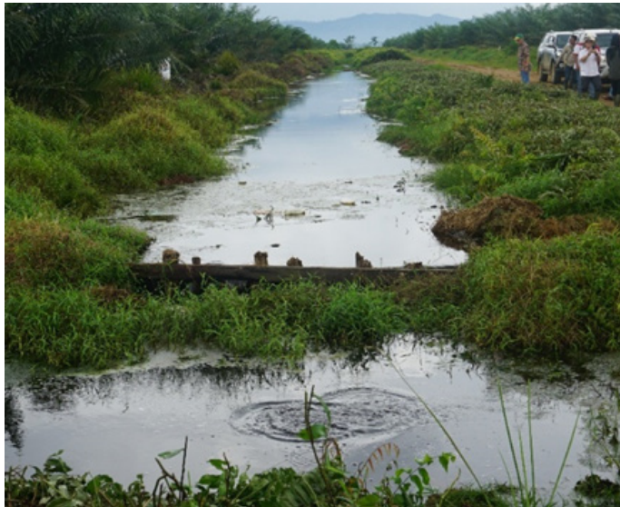
Gambar 6.18 Sekat Kayu Satu Lapis ( Plank Dam ) di PT PKM, Supervisi Deputi III BRG RI, 2019
