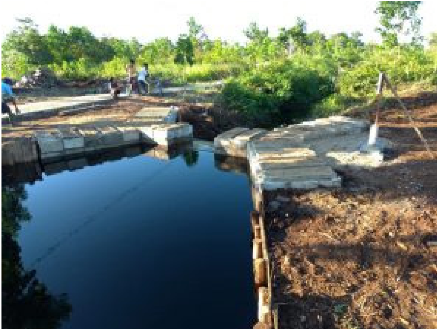
Gambar 6.5 Pembangunan Sekat Kanal di Lahan Gambut
