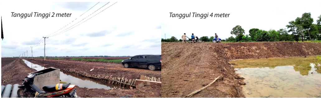
Gambar 6.36 Ketinggian Tanggul Pada Polder PT Buyung Poetra Sembada Sumber : Direktorat Pengairan dan Irigasi, Bappenas
