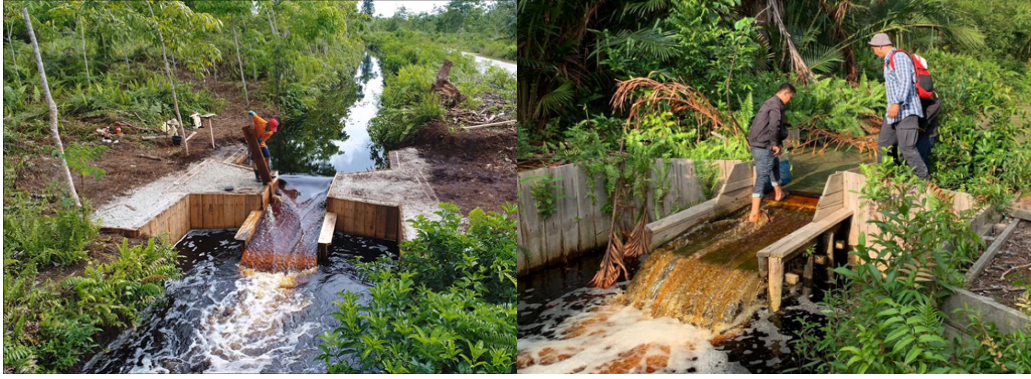
(a) (b) Gambar 6.19 Sekat Kayu Multilapis dengan Peluap Sumber : Universitas Riau – BRG, tahun 2017 dan 2019
