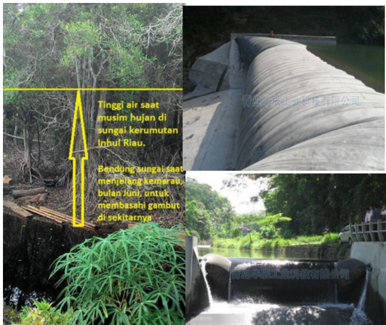
Gambar 6.4 Sungai Kerumutan dibendung dengan beberapa Bendung Karet
