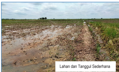
Gambar 6.45 Lahan dan Tanggul pada Polder Petani Mandiri Seluas 2 Hektar Sumber: Direktorat Pengairan dan Irigasi, Bappenas
