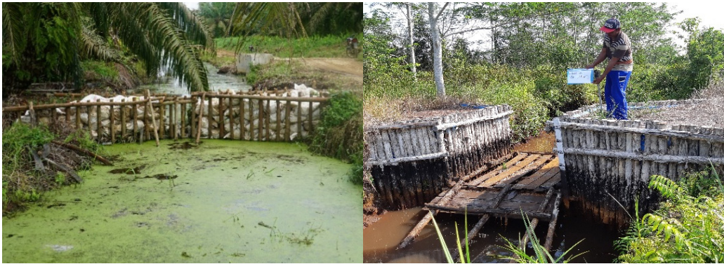
(a) (b) Gambar 6.20 Sekat Kayu Multilapis Tanpa Peluap, Supervisi Deputi III BRG RI, 2019 Sumber : Balai Litbang Rawa, 2018 (Kontributor foto : Budi Triadi)
