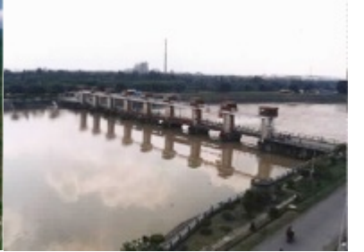
Barrage Lengkong Baru
