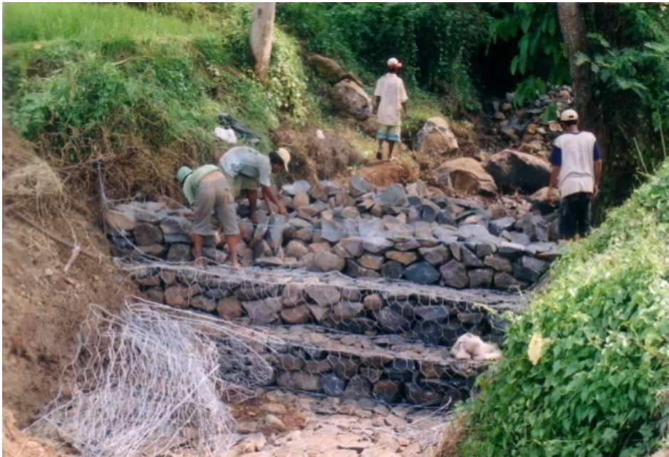
Check-dam untuk kendalikan erosi lahan
