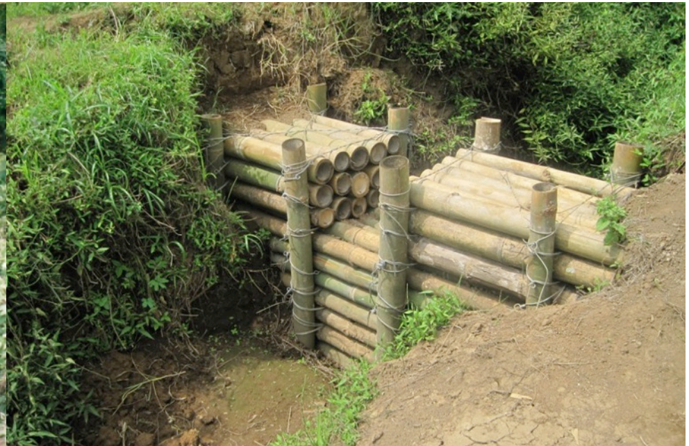
Gully-plug dari bahan “ramah lingkungan”
