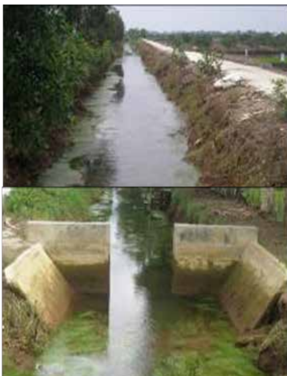
Gambar 4. Kondisi Saluran Tersier dan Model Tabat Beton pada Desa Karang Buah
