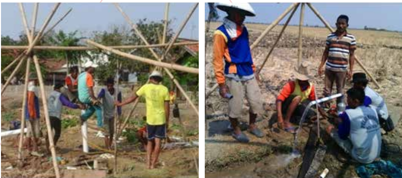
Gambar 3.14 Pemboran sumur air tanah dangkal dan dalam
