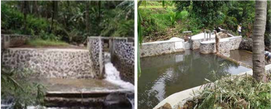
Gambar 3.8 Dam Parit dengan biaya pembangunan Rp100 juta dikerjakan dengan swakelola masyarakat/petani
