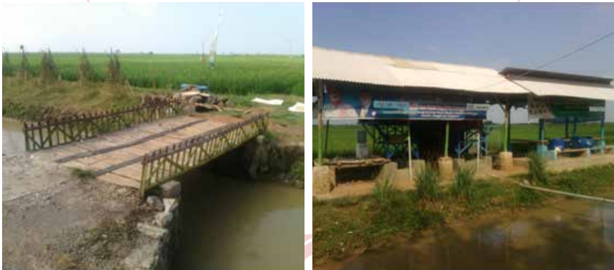
Gambar 3.20 Pembangunan jembatan dan rumah pompa dari hasil pengelolaan air tanah
