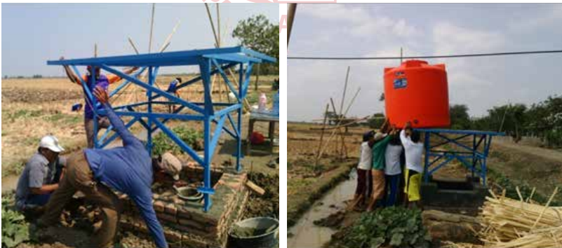
Gambar 3.15 Pembangunan menara air
