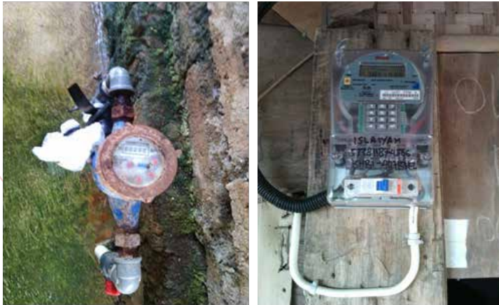
Gambar 3.17 Pemasangan flow meter dan kWh meter
