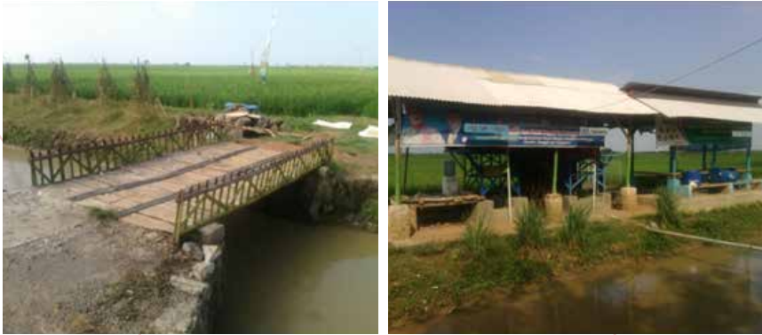
Gambar 3.21 Pembangunan jembatan dan rumah pompa dari hasil pengelolaan air tanah
