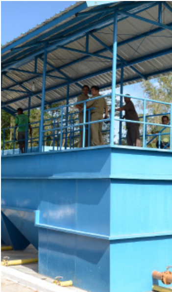
Ditjen Cipta Karya Evaluasi Pembangunan Infrastruktur Air Bersih melalui CSR PT. Pertamina di Kabupaten Ende
